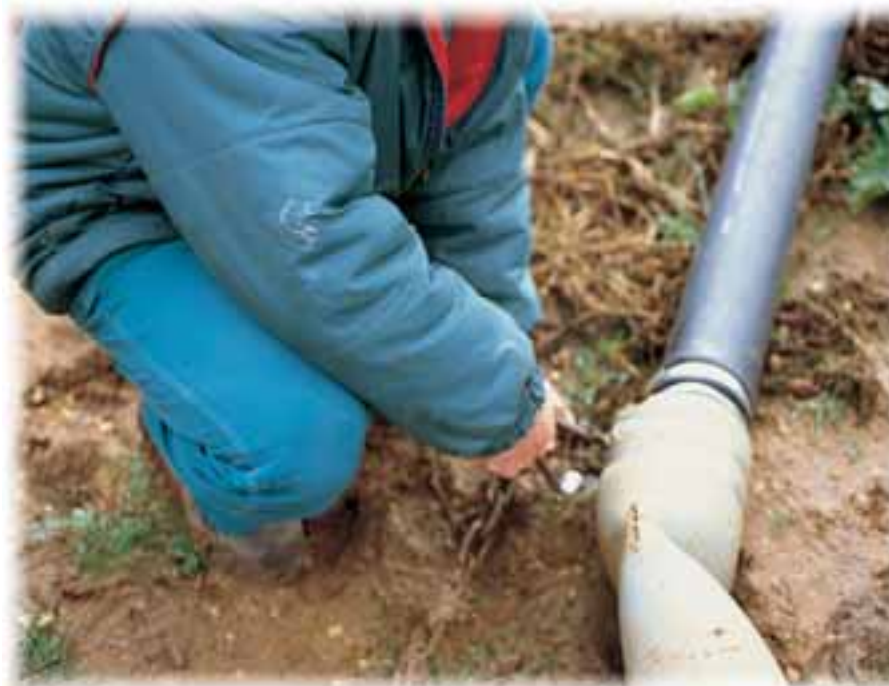
Operación de un cambio de manguera en un pivote lateral
